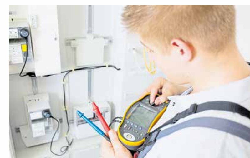
Acht Handwerkerinnen und Handwerker haben eine Fortbildung im Bereich Gebäudeautomation gestartet. Foto: www.amh-online.de
