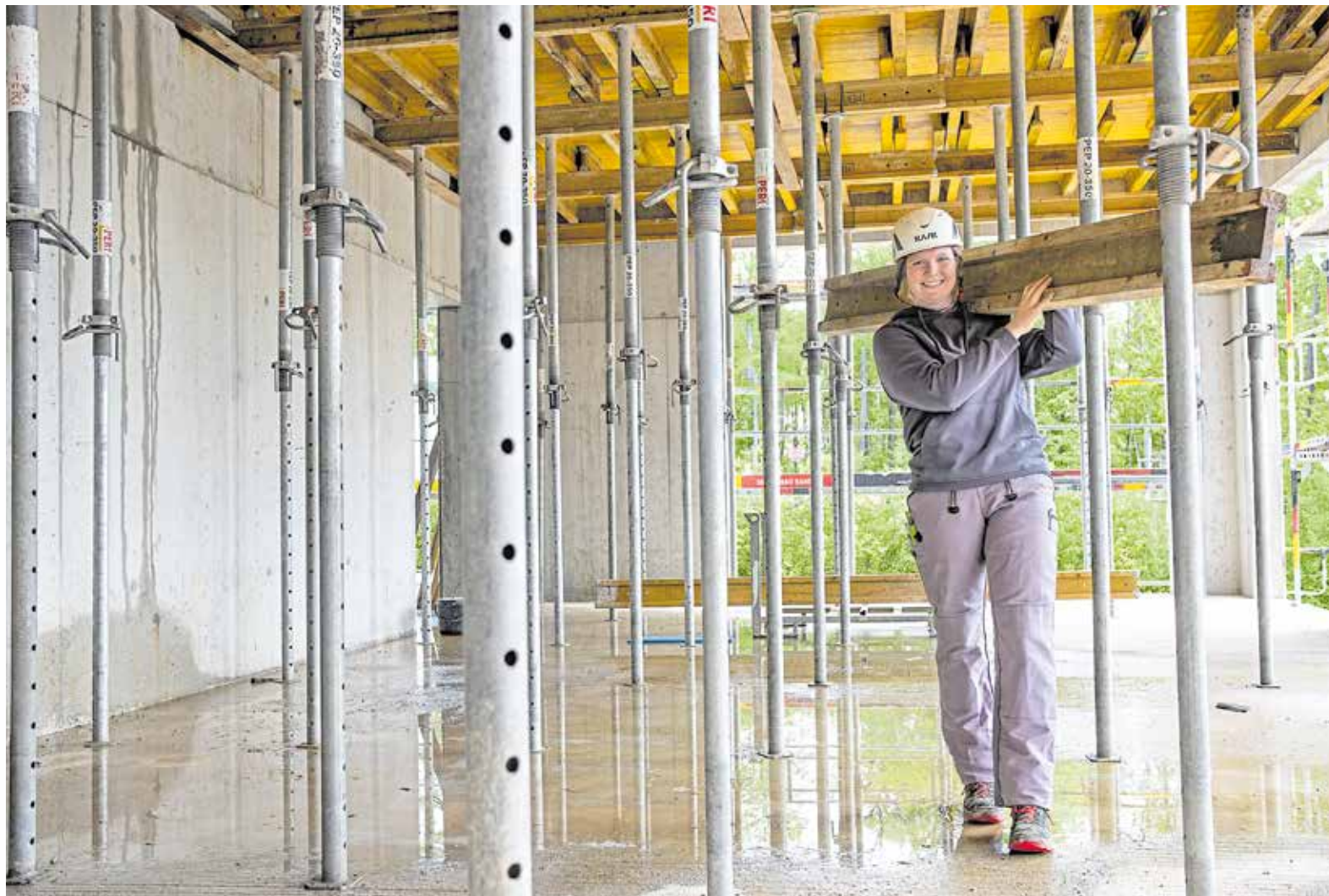
Mareike Schäufele aus dem Alb-Donaukreis macht ihre Ausbildung zur Maurerin bei UC Monz GmbH und Co. KG in Heidenheim. Gemeinsam mit ihren Kollegen arbeitet sie aktuell auf einer Baustelle am Klinikum in Heidenheim.
