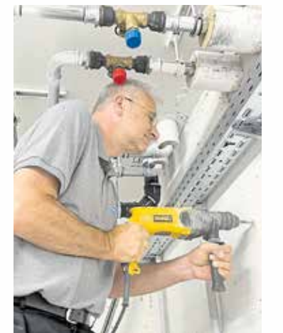
Der Hauptgeschäftsführer packt auf der Baustelle mit an. Foto: Handwerkskammer
